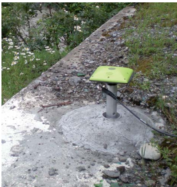
Рис. 3. Вверху – геодезический маркер с анкерным болтом, штатив для крепления антенны (вертикальный цилиндр) и защитный колпачок на резьбу маркера. Внизу – пример установки мобильной GPS-антенны JAVAD на геодезический маркер на пункте HVCE
