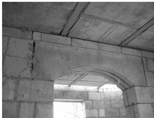
Рис. 5. Арочная и брусковая перемычки из фибропеножелезобетона
