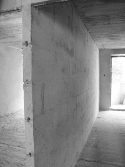
Рис. 2. Межкомнатная перегородка из блоков пазошпоночной формы
