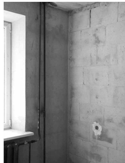
Рис. 3. Интерьер после проведения электротехнических работ, крепления отопительного оборудования и шпатлевания стен
