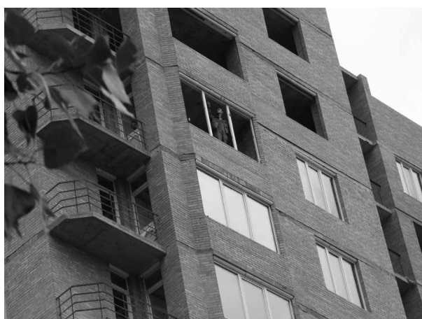
Рис. 4. Монтаж оконного блока в галтель, закрепленную на перекрытии
