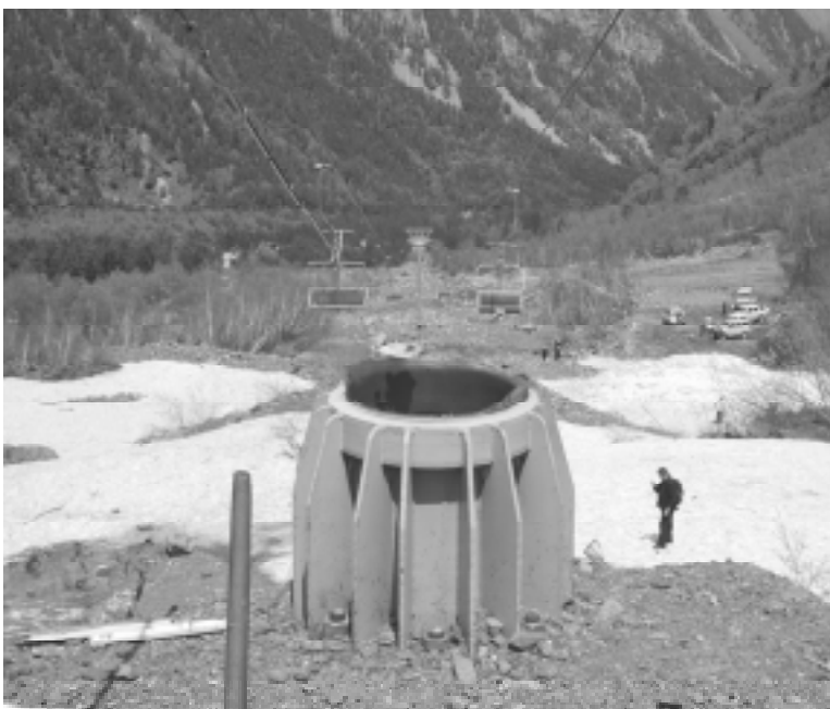
Срезанная опора канатной дороги, 2005 г.
